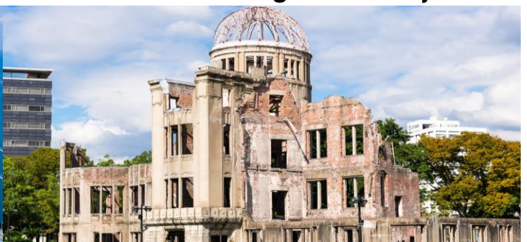
A-bombed Dome - Hiroshima
